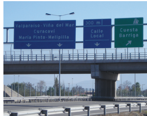
Las señales de tránsito informativas colocadas en altura sobre la calzada facilitan la selección de la pista correcta.
